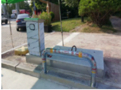
<충전시설 설치전 전경(실외)>
